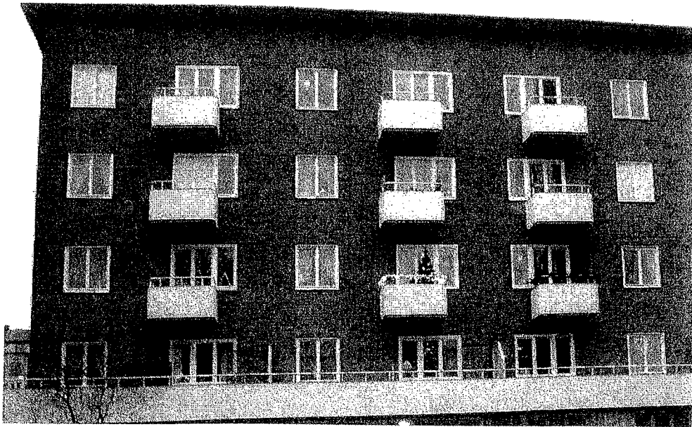
Referensprojekt. Bild från Stockholmshems hus på Högbergsbacken vid parken på Rosenlundsgatan. (Observera att våra balkonger ska sitta mitt för fönstren av konstruktionskäl.)
